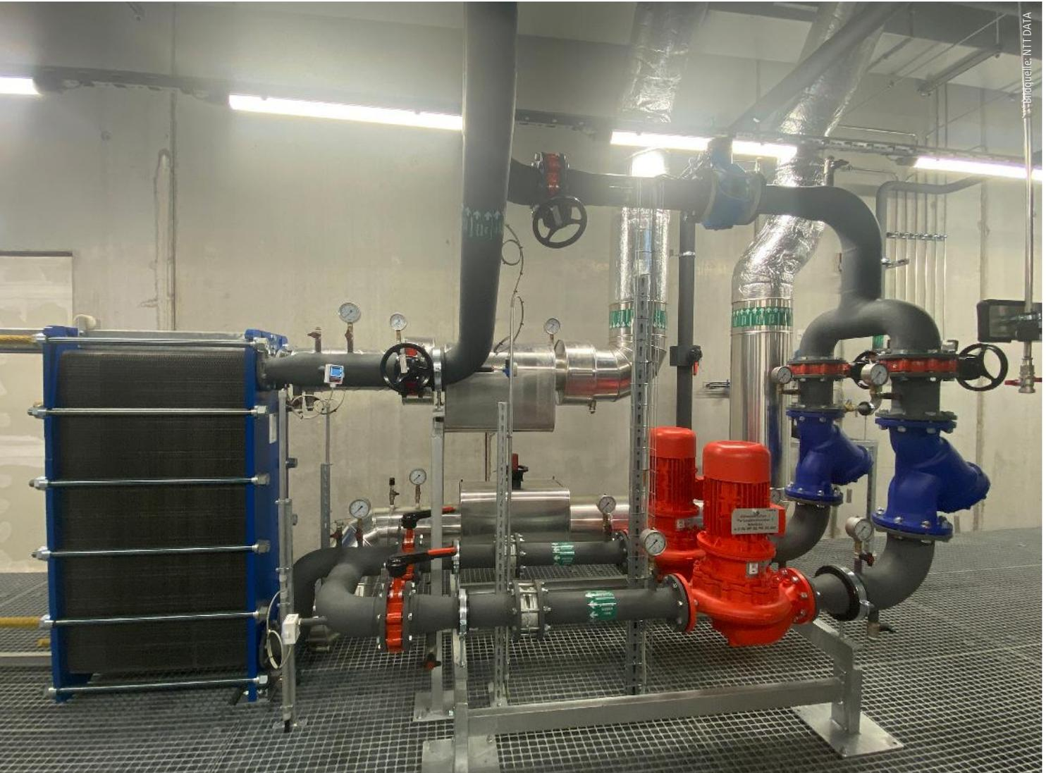
Technikzentrale des Rechenzentrums „Berlin 2“ des Betreibers NTT Ltd. mit dem Wärmetauscher für die Abwärmeauskopplung
